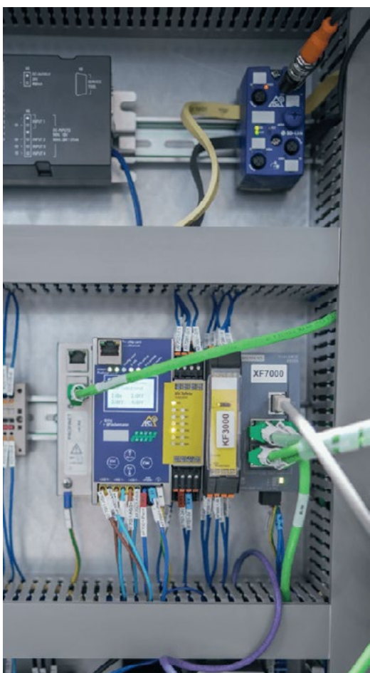
För att utnyttja processdata kan IO-Link-givare enkelt integreras i befintliga ASi-nätverk via ASi-5-moduler med integrerade IO-Link-masters (ovan) och ASi-5/ASi-3-Safety-gateways (nedan) från Bihl+Wiedemann
