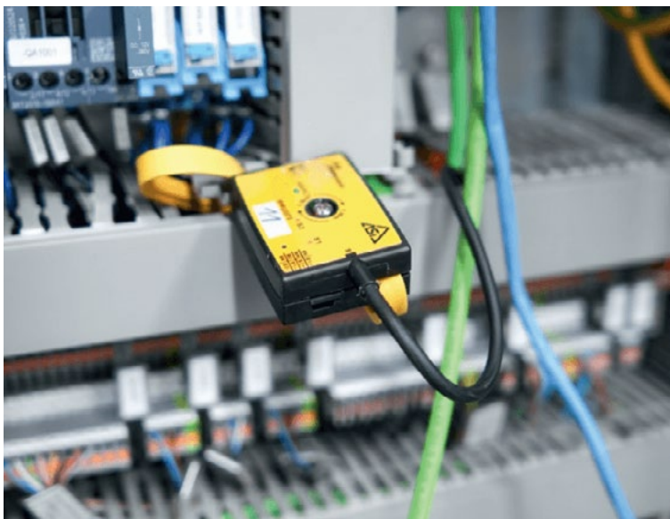
Aktiv distributör ASi Safety BWU3373 från Bihl+Wiedemann för integrering av säkerhetsbrytare i ASi-nätverket.
