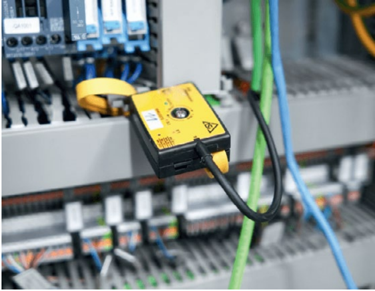
Distribuidor activo ASI Safety BWU3373 de Bihl+Wiedemann para la integración de interruptores de seguridad en la red ASI
