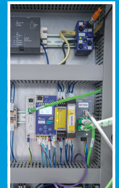
Für die Nutzung von Prozessdaten können IO-Link Sensoren einfach über ASI-5 Module mit integrierten IO-Link Mastern (oben) und ASI-5/ASI-3 Safety Gateways (unten) von Bihl+Wiedemann in bestehende ASI Netzwerke integriert werden.
