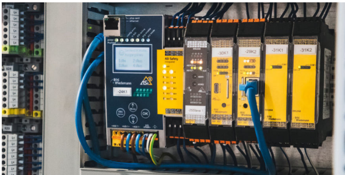
Sicherheitstechnik im Schaltschrank: ASi Safety Gateway (links) und Safety Basis Monitore (Mitte) von Bihl+Wiedemann.
